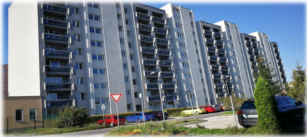
Fotografia po rekonštrukcii budovy
